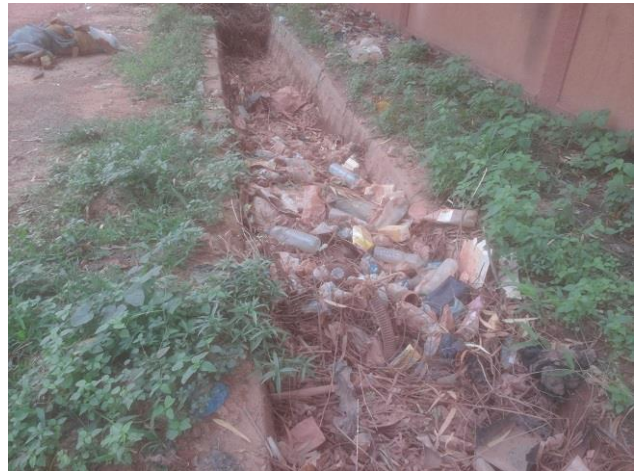
Avec un tel caniveau, impossible pour l'eau de circuler
