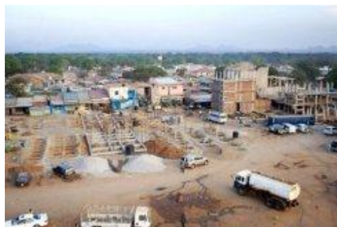
Un chantier dans un quartier de Juba, ville en pleine construction, le 12 janvier 2011
